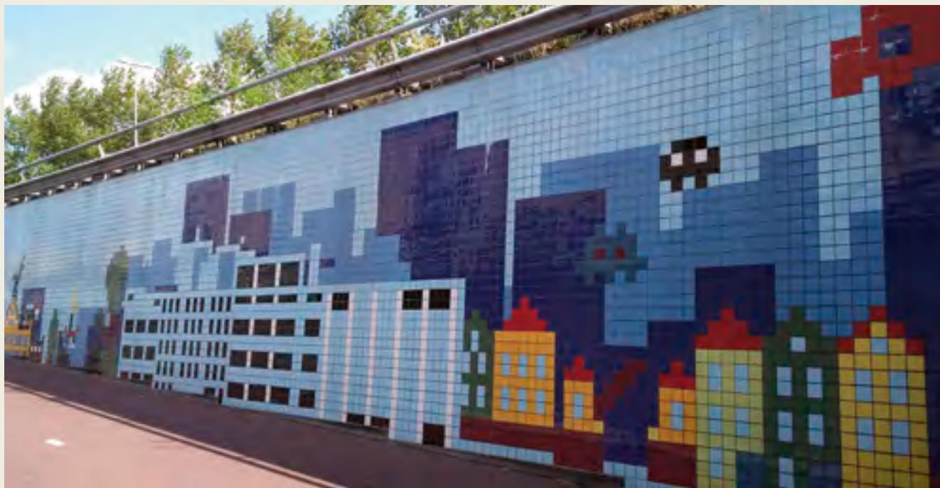
Tunnel Ciclovía - Olanda
